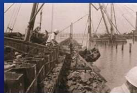
昭和45年 神野埠頭岸壁工事 擁壁裏込め投入
